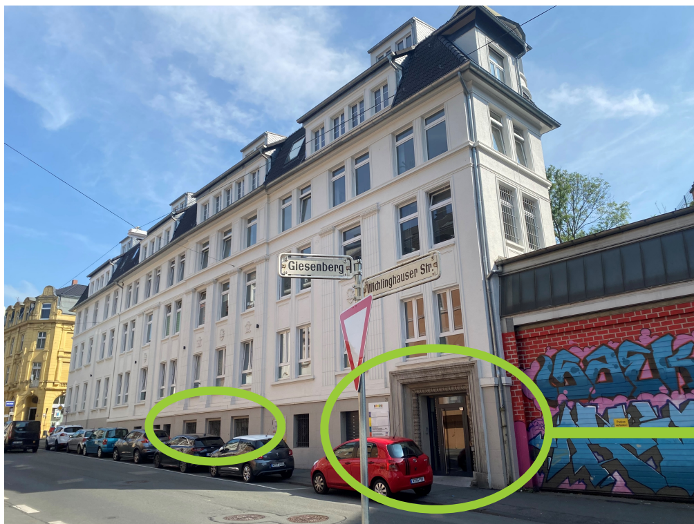
Haupteingang an der Wichlinghauser Straße und die 3 Fenster des neuen Raums
